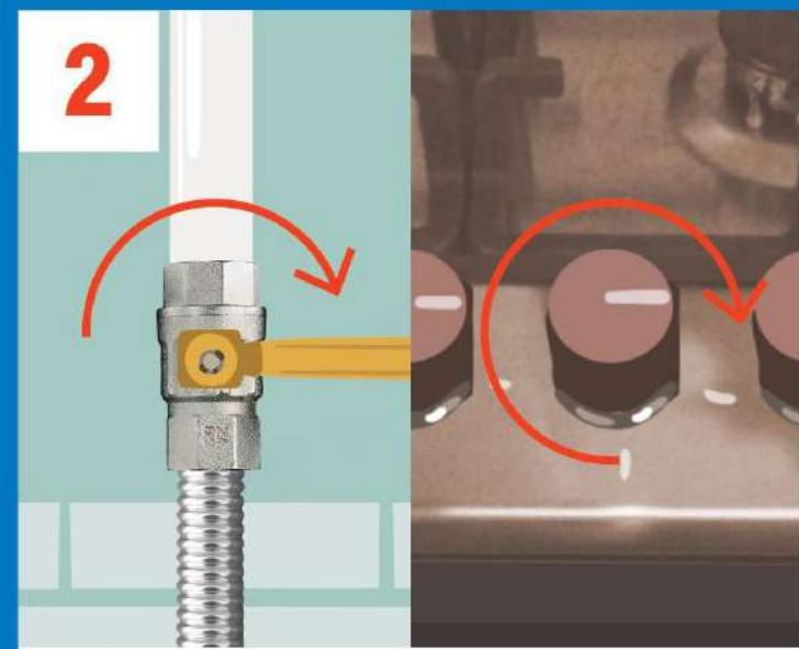
Закройте вентили на газопроводах и краны на приборах
